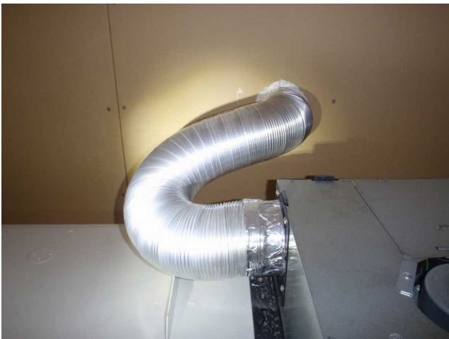
【天井裏】 浴室換気扇配管 問題ありません。
