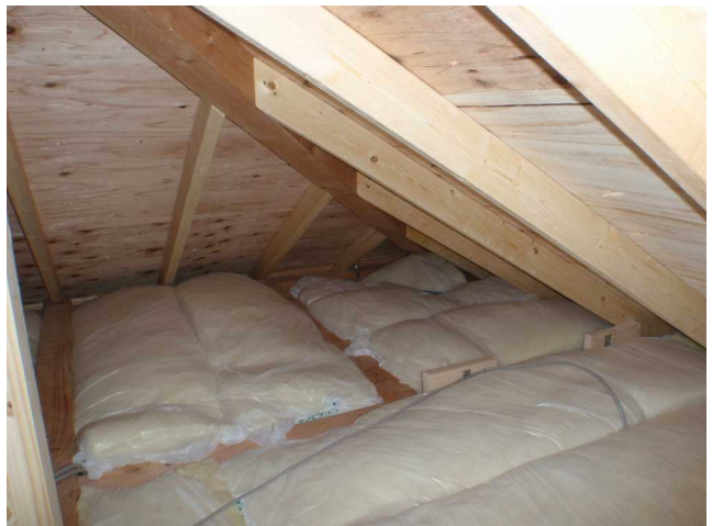
【小屋裏】 断熱や小屋組の施工状態は特に問題ありませんでした。
