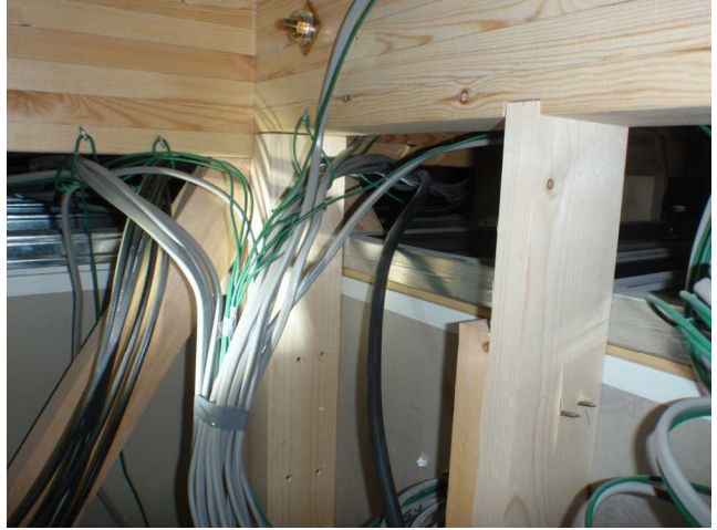
【筋かい金物】 図面に記載されている筋かいは見える範囲で全て確認できました。
