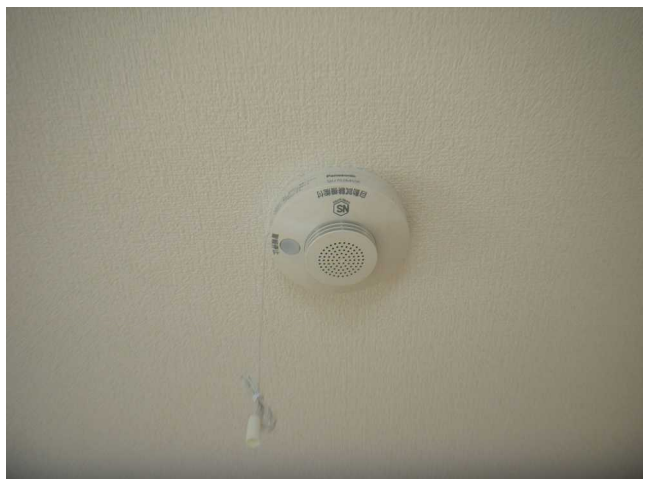
【室内】 住宅用火災報知器の作動確認を行いました。問題ありません。
