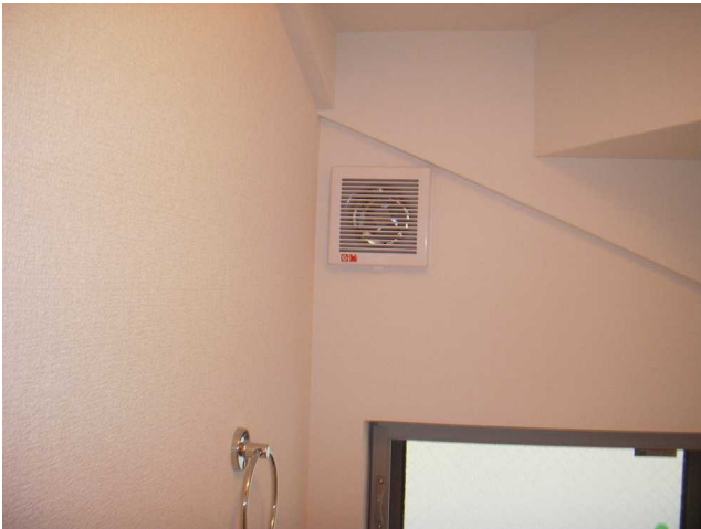
【室内】 浴室、洗面、トイレやキッチンの換気扇の作動状態を行いました。正常に作動していました。
