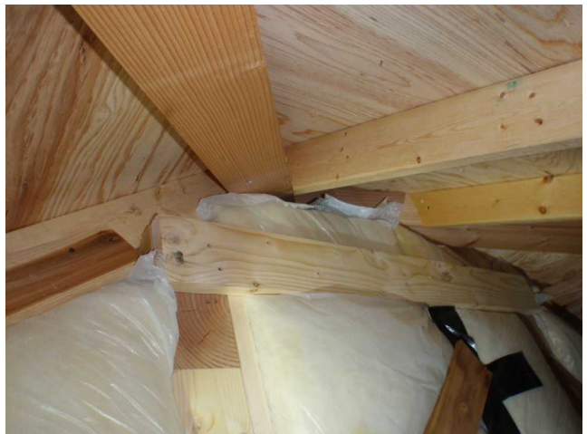
【小屋裏】 断熱や小屋組の施工状態は良好です。
