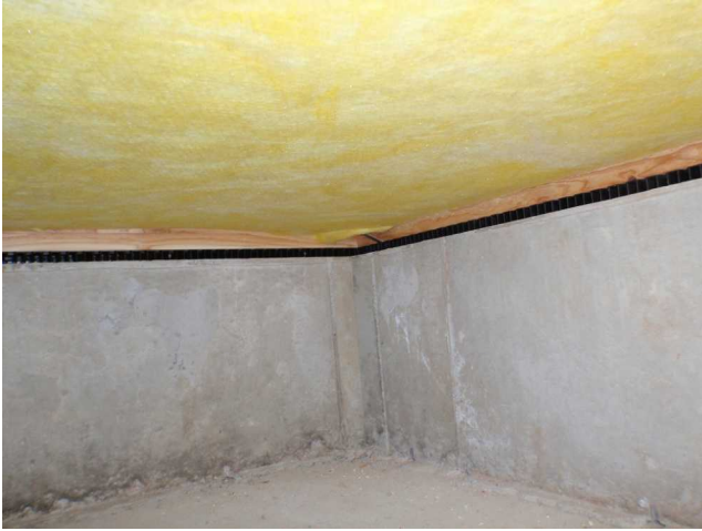
【床下】 基礎立ち上がり 亀裂や変色その他施工不良箇所はありませんでした。
