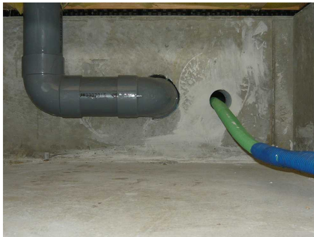
【洋室 点検口直下】 洋室 点検口直下にある床暖房配管用の穴は、基礎工事完了後に空けられていました。
