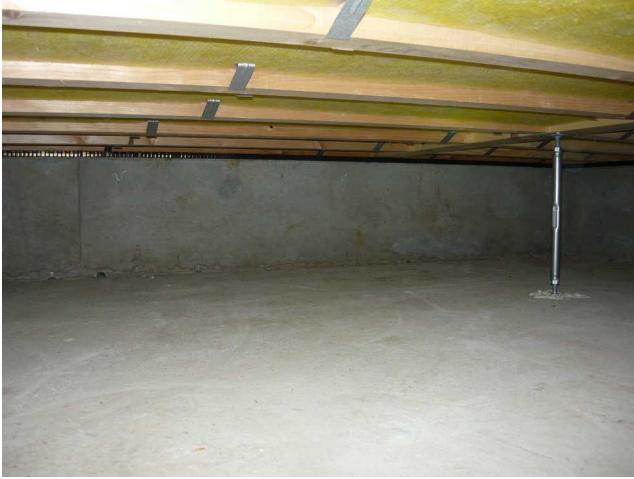
【洋室下】 洋室下の様子です。 基礎パッキン、床断熱材、基礎の立上りなど、特に問題ありませんでした。
