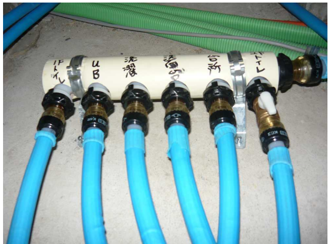
【給水ヘッダー】 給水を分岐するためのヘッダーです。 特に問題ありませんでした。
