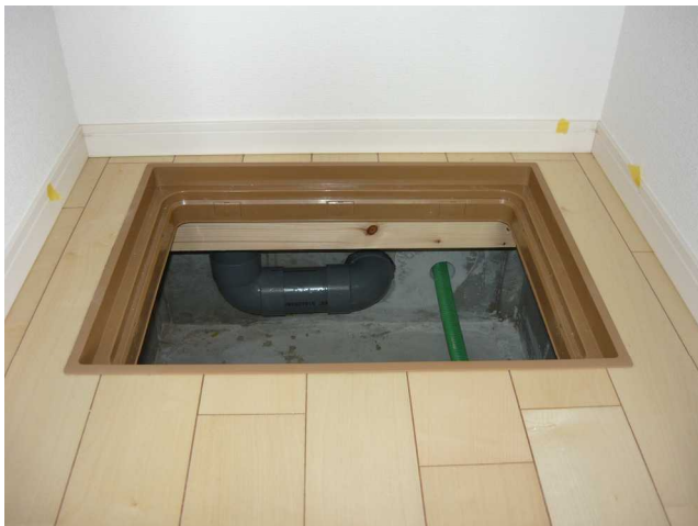
【洋室 点検口】 洋室の点検口から、床下を確認しました。
