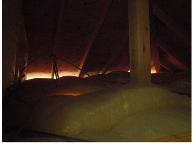
【換気口】 明かりが見えるのは軒先換気口からもれる外の明かりです。 光が漏れていることから、外部と繋がっていることが分かります。
