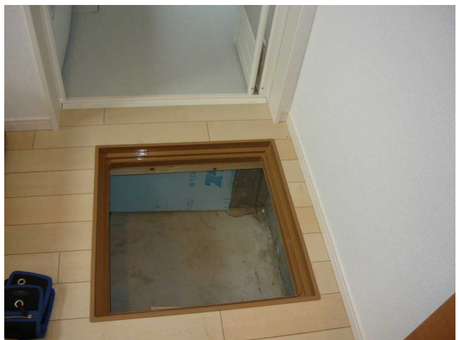
【洗面脱衣室 点検口】 洗面脱衣室の床下点検口から、床下を確認しました。
