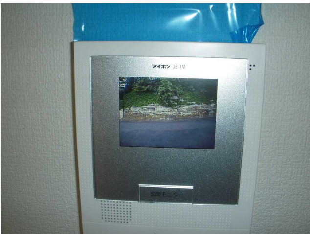
【インターホン】 インターホンの室内側のモニターの状態です。カラーモニターが設置され、受像状態も問題ありませんでした。
