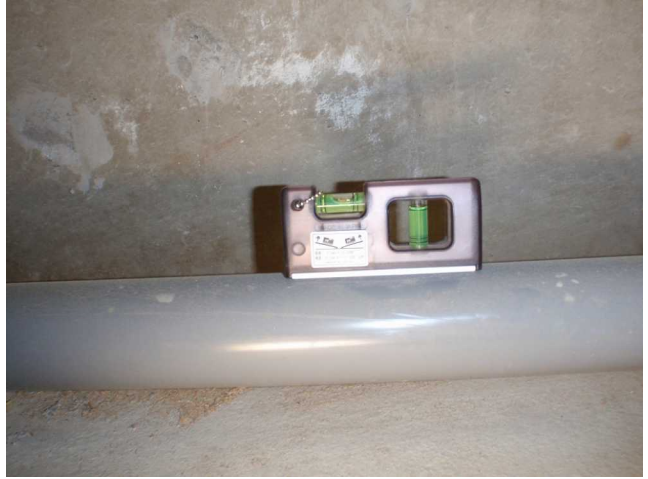
【床下】 排水管 漏れ、勾配不良などはありませんでした。
