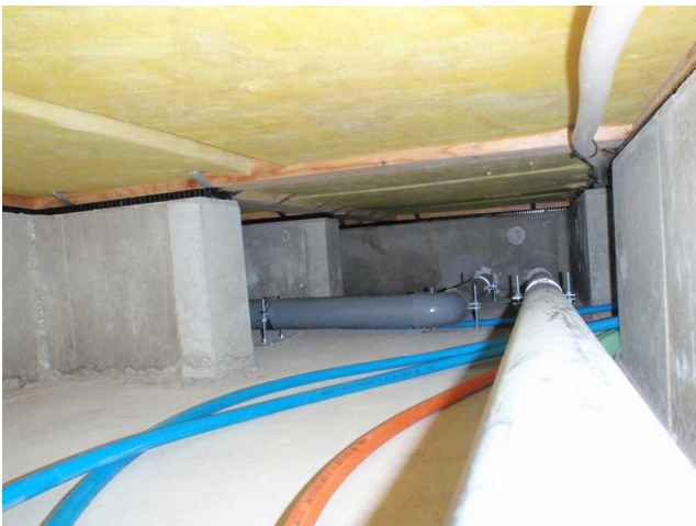
【床下】 給水、排水管 漏れなどはありませんでした。
