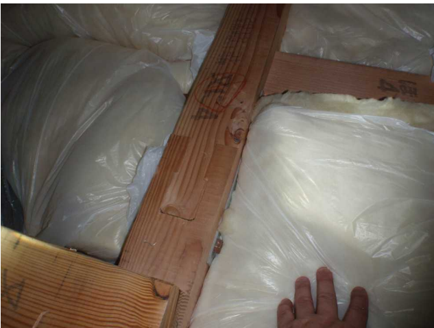
【金物】 金物の施工状態は良好でした。
